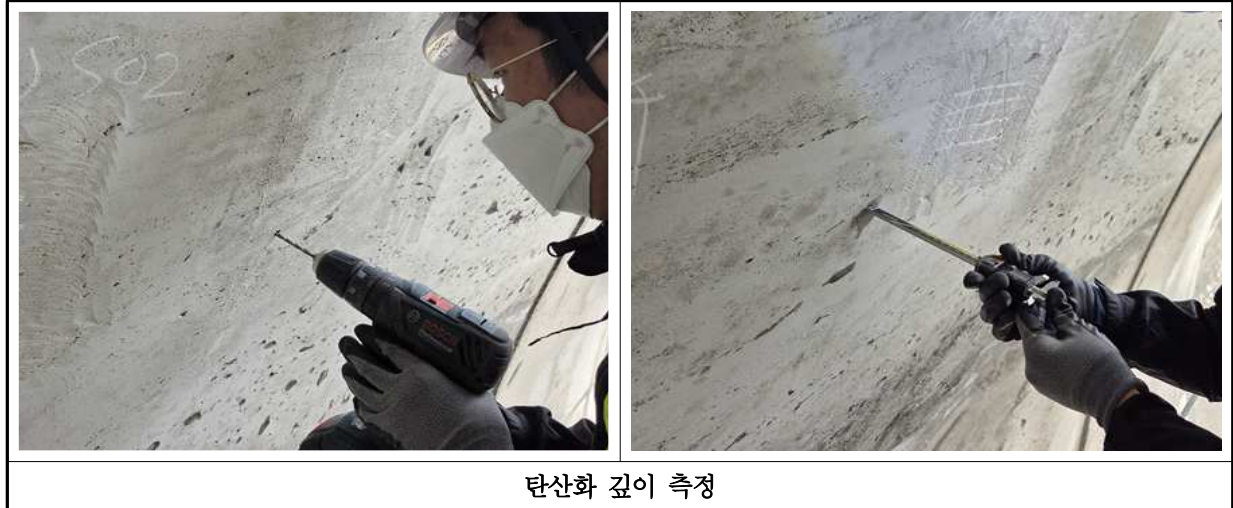
【사진 2.4.2】 탄산화 깊이 시험 현장사진
